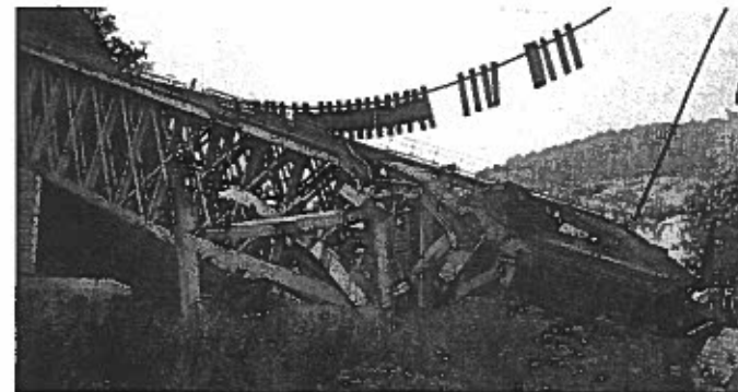
Le pont de Remouchamps après le plasticage du 8 août 1944. (69)
